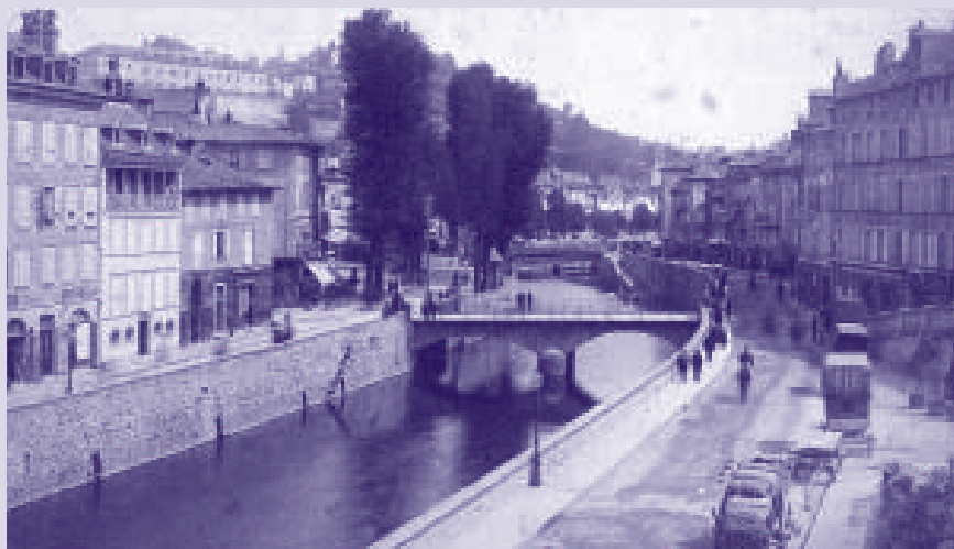
Les quais de la Corrèze, le pont Choisinet (AD19, 22F1165)
